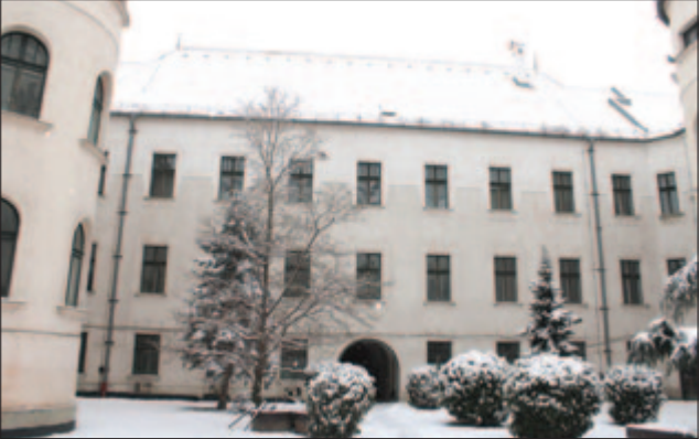
A belső udvart is felújítják
